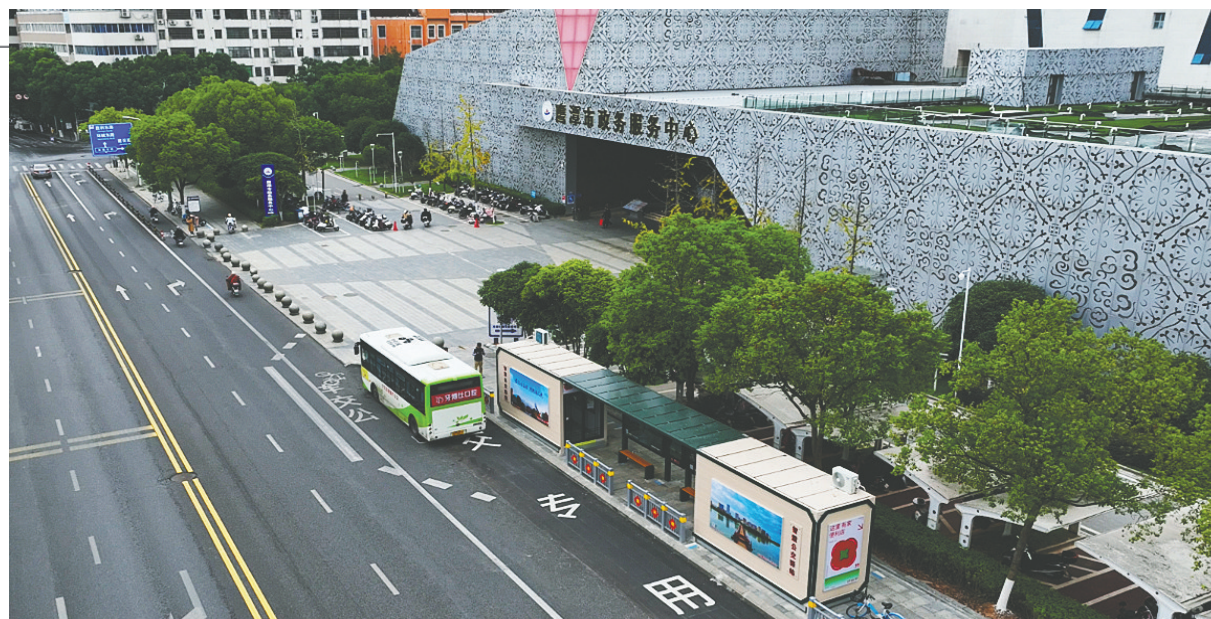
鹰潭市政务服务中心门前新修建的智能公交驿站
